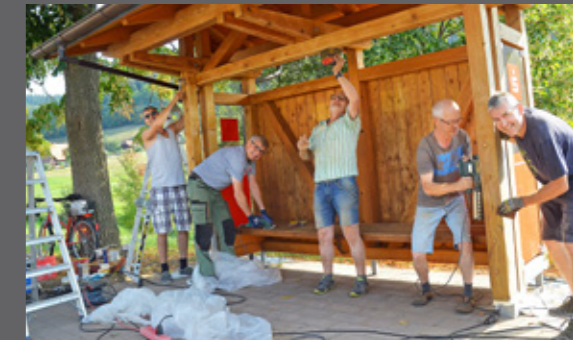
Gerhard Himmelsbach (l.) und seine Helfer beim Renovieren des Wartehäuschens
